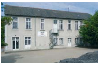
La salle des Aralias sera démolie aussitôt la mise en service de la nouvelle Salle.
