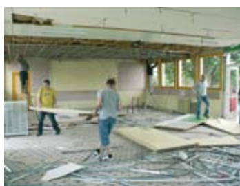
Démolition des cloisons et plafonds des anciens locaux.
